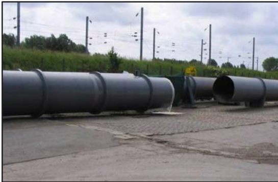
Secciones de tubería antes de la protección con ARC S4 + .
